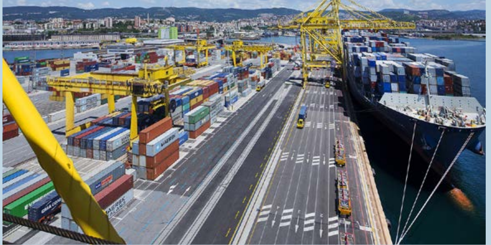
Panoramica del Molo VII, il terminal container del Porto di Trieste gestito da TMT
